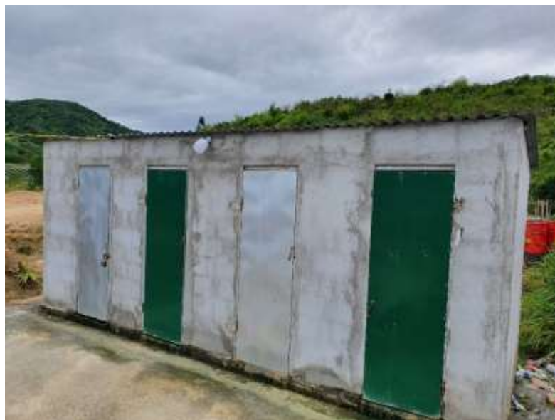
Hình 5. Nhà vệ sinh (kết cấu bằng bê tông cốt thép 3 ngăn)
